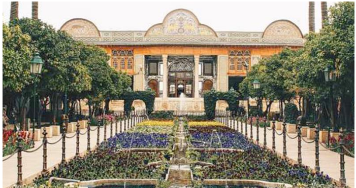
تصویر ۱. نمای ساختمان شمالی بنای نارنجستان قوام. منبع: نگارندگان.
