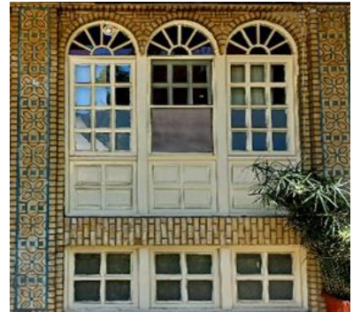
تصویر ۷. آرایه‌های آجرکاری و کاشی کاری دیوارهای درونی و بیرونی باغ. منبع: نگارندگان.
