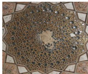
تصویر ۲. کپبری، سقف اتاق عمارت هشت‌بهشت. منبع: نگارندگان.
